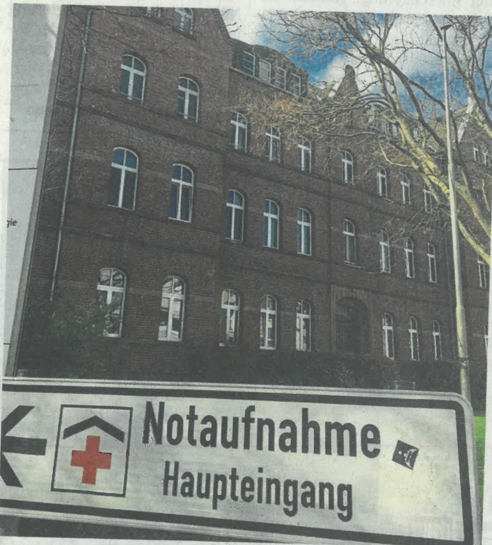
Im Marienhospital eröffnet Anfang April die zentrale Notdienstpraxis für Brühl, Erftstadt, Hürth und Wesseling.
