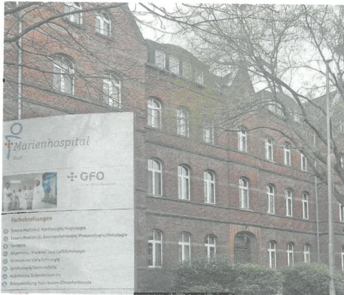
Die Geschäftsführung des Marienhospitals Brühl plant, das Krankenhaus zu vergrößern. Anfang 2020 sollen die Bauarbeiten beginnen. (Foto: BB)
